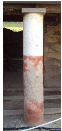
Figg. 17-18: colonne del Portico, erosione dell'intonaco.
