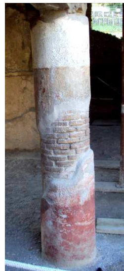
Figg. 17-18: colonne del Portico, erosione dell'intonaco.
