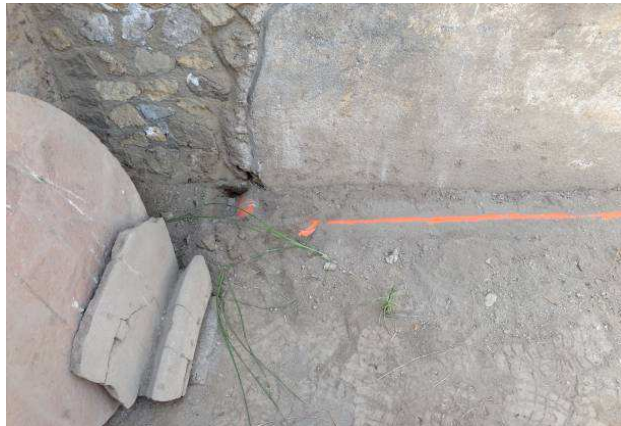
Fig. 9: uscita della condotta dal muro della Cella Vinaria.
