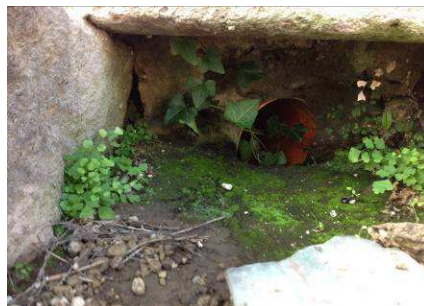
Fig. 10-11: scarico del pluviale P2 verso l'antico pozzetto di decantazione presso la cisterna. Fig. 12: condotta nel Locale Pozzo.
