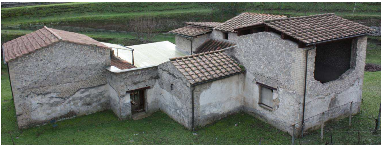
Fig. 4: vista nord-ovest della villa: da destra il pluviale P4 (Calcatorium), il P5 (Cucina) e il P6 (Triclinio-Fienile). All'interno del Cortile si vedono, da destra, il P2 ed un pluviale di raccordo tra la copertura trasparente del Portico Nord e la gronda verso il P1.
