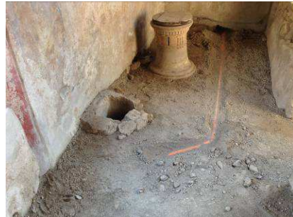
Fig. 10-11: scarico del pluviale P2 verso l'antico pozzetto di decantazione presso la cisterna. Fig. 12: condotta nel Locale Pozzo.
