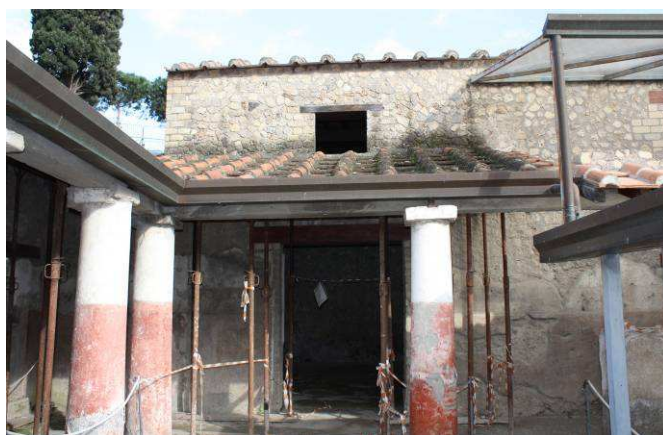
Fig. 7: vista del Portico Nord, con l'innesto dei pluviali P7-P7bis sulla gronda della copertura trasparente della Cella Vinaria.
