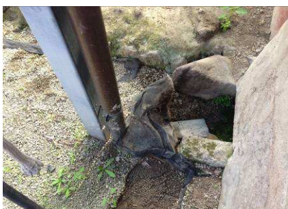
Fig. 10-11: scarico del pluviale P2 verso l'antico pozzetto di decantazione presso la cisterna. Fig. 12: condotta nel Locale Pozzo.
