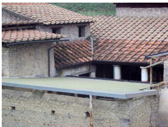
Fig. 6: vista della copertura del Portico da est, a sinistra sono visibili i pluviali P2 e P1-P1bis, collocato più in basso, a destra i pluviali P7 e P7bis.
