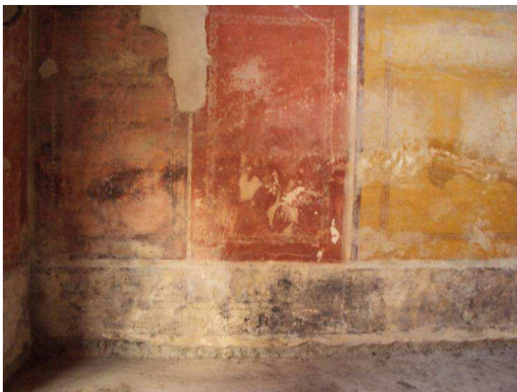
Fig. 16: parete ovest del Triclinio: evidente la curva di risalita capillare.
